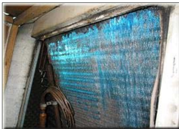
Fig. 1-1 증발기의 심각한 오염 상태
