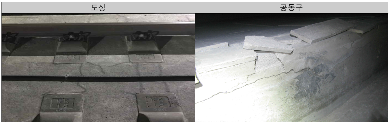
그림 2.7 궤도 및 공동구 상태(수도권 B)
