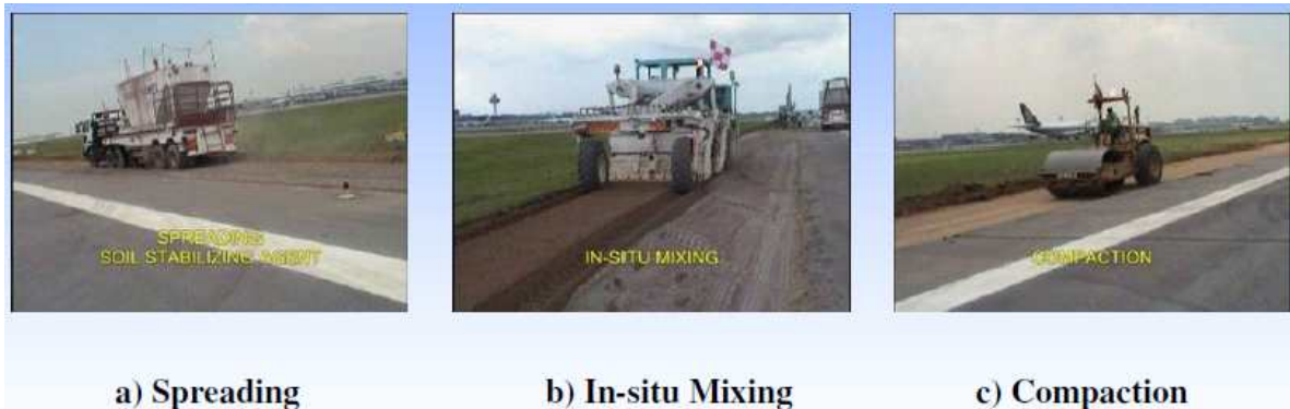
[그림 2.4.5] Singapore Changi International Airport의 현장토처리 기법을 이용한 활주로 확장 시공 모습 (2005)
