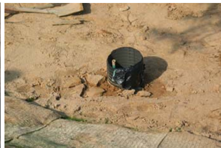
(d) 집수정 설치 완료
