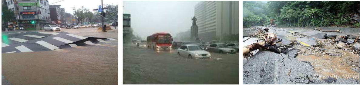
그림 1.6 집중호우로 인한 도로침수 및 포장파손 사례
