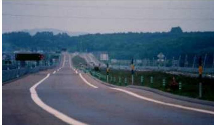
그림 2.7 일본 토탄성 연약지반에 시공된 도로
