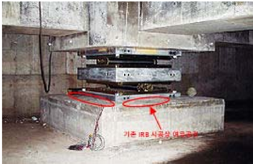
그림 3.18 기존 롤러 슬라이딩식 받침(IRB)
