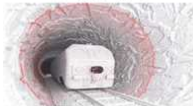
터널 내공단면 측정
