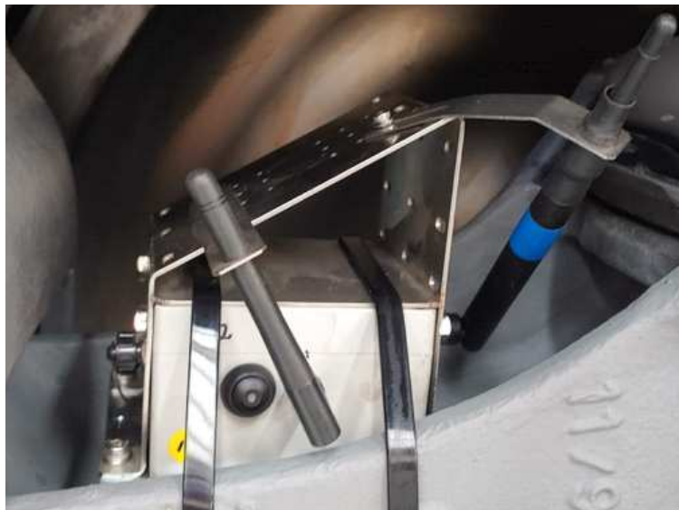
<그림 2.163> 무선가속도계 설치 후 사진
