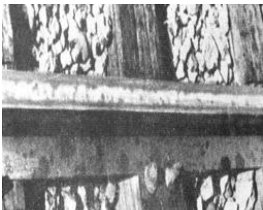
<그림 2.10> 스폐링(Spalling) 발생 사진
