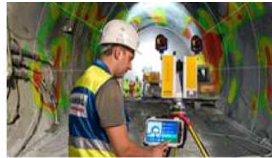
터널 내공단면 측정
