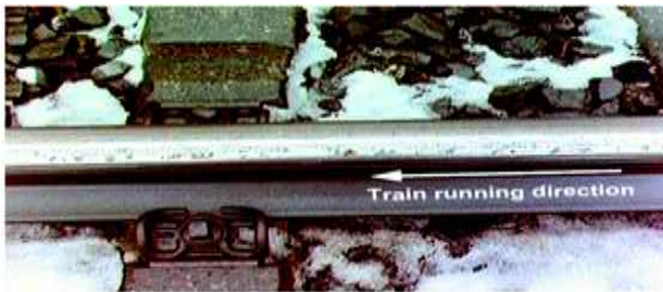
<그림 2.9> 헤드체크(Head Checks) 발생 사진
