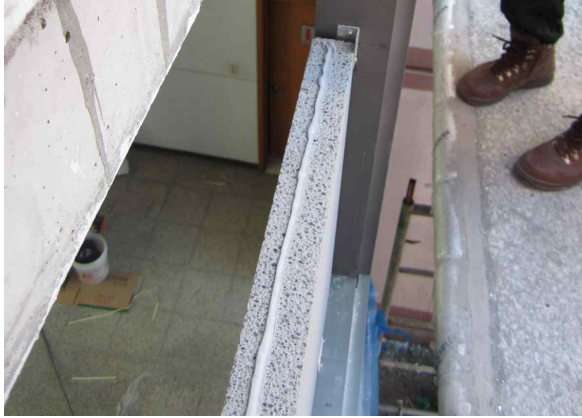
<그림 3.144> 방화실란트 도포
