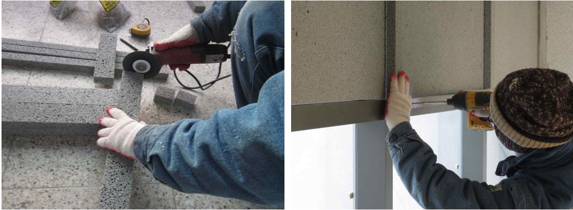
<그림 3.107> 커튼월 프레임 커버 설치
