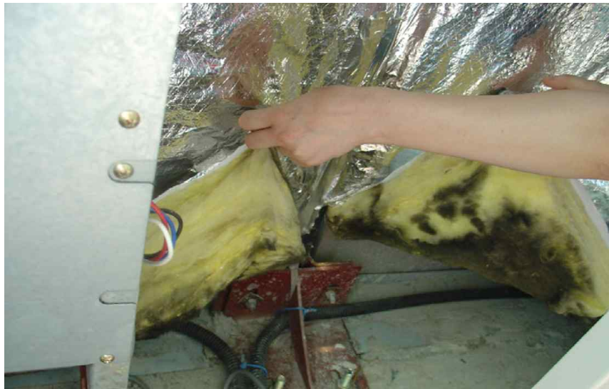
<그림 3.31> Back Panel에 사용된 Glass Wool 단열재의 결로발생 및 변형
