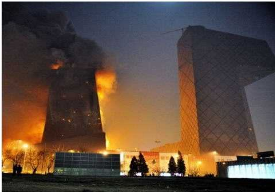
<그림 2.3> A급 불연 단열재의 사용계기가 된 CCTV 화재(중국) (유기단열재의 사용으로 인한 화재 사례)
