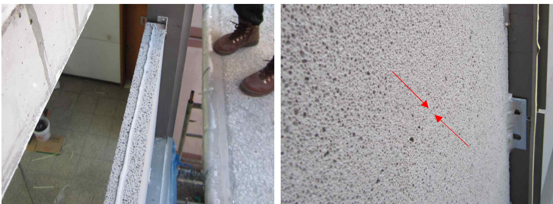
<그림 3.106> 경량무기발포 세라믹보드 접합 조인트
