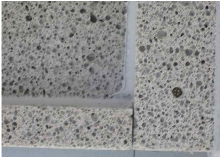
<그림 3.148> 경량무기발포 세라믹보드 설치 후 실링작업
