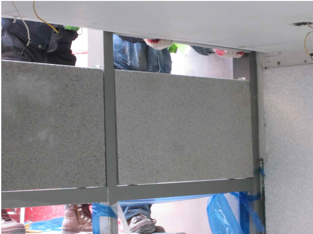
<그림 3.113> 경량 무기발포 세라믹보드 설치
