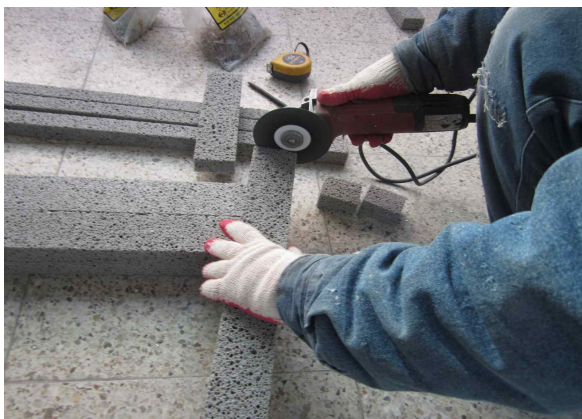
<그림 3.146> 커튼월 프레임 커버 절단
