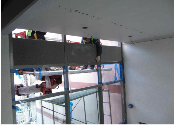
<그림 3.142> 경량무기발포 세라믹보드의 최하단 설치
