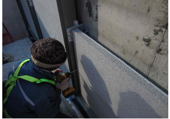
<그림 3.143> 경량무기발포 세라믹보드와 프레임간 고정
