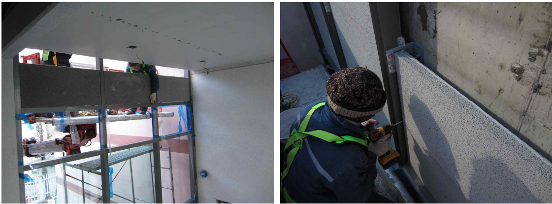
<그림 3.105> 무기발포 세라믹보드 설치
