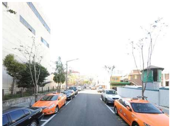
사업 후 - 전선 지중화 및 담장 정비
