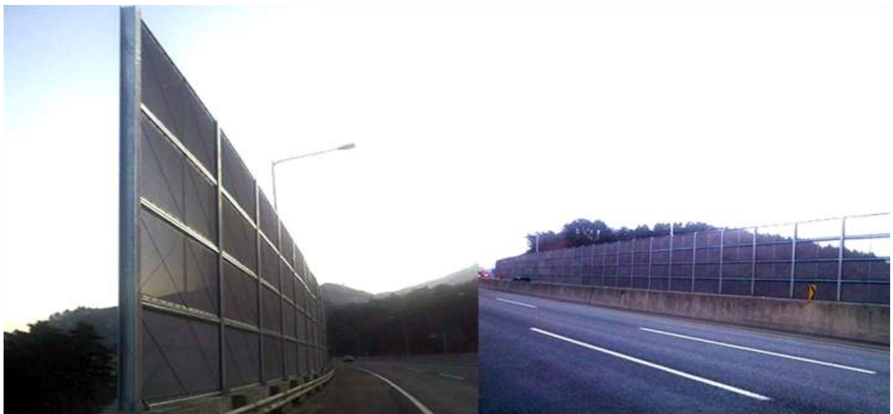
그림 2.2.1 대관령 구간 방무벽 설치 사진
