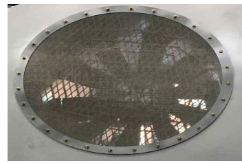
송풍기 및 이중겔로필터 결합
