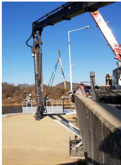
교각 하단 설치
