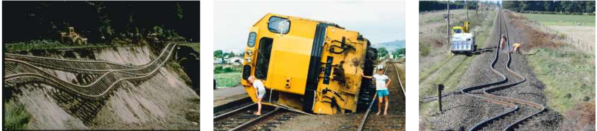
그림 1.1. 지진에 의한 철도 파손 및 열차 전복 사례
