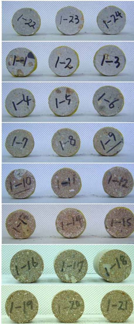
그림 46. 콘크리트 코어 단면사진 (상부로부터 각 0, 7, 14, 21, 35, 42, 49, 77일 경과 후)
