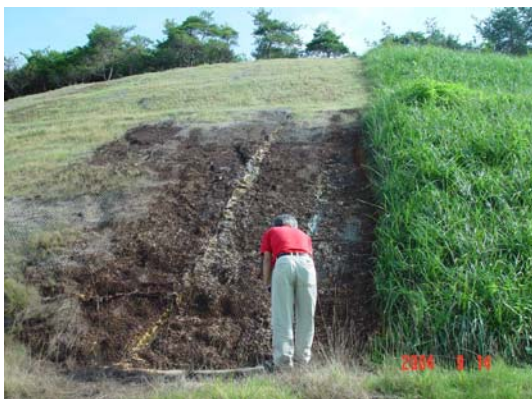
그림 21. 산성배수에 의한 식생공 적용의 실패사례.
