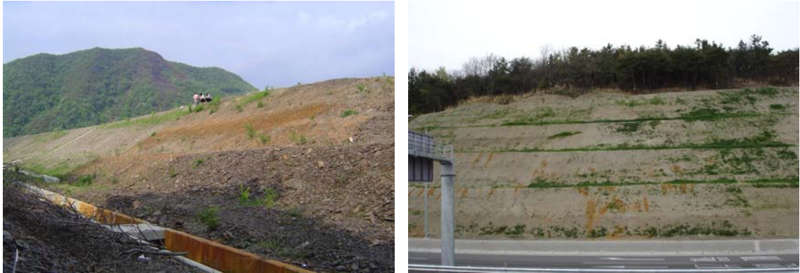
그림 76. 산성암반배수가 발생하는 성토사면과 절취사면에 적용된 식생공의 실패 사례.
