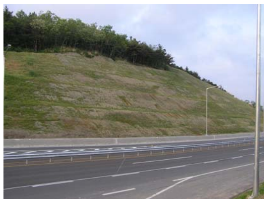
그림 24. 생석회 살포 후 식생공이 적용된 사면.
