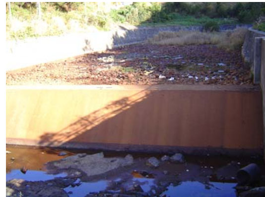
그림 31. 성토층으로부터 발생된 산성 배수에 의한 지표수 오염.
