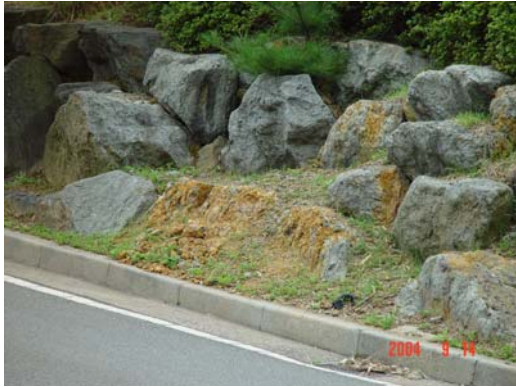
그림 15. 황철석의 산화에 의한 암석풍화의 가속화.
