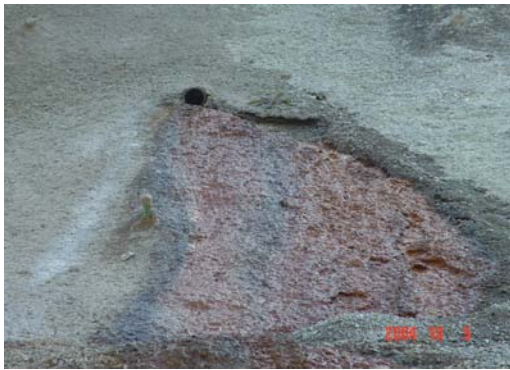
그림 17. 콘크리트피막의 표면부식.
