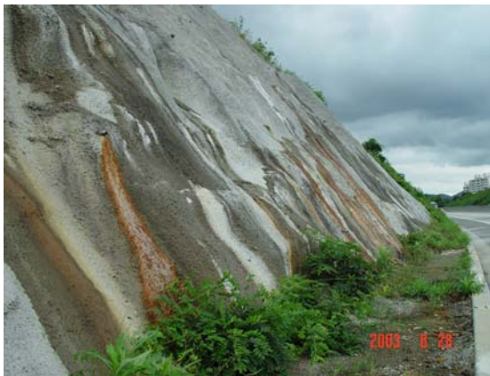
그림 25. 슛크리트 표면의 침전물에 의한 경관훼손.
