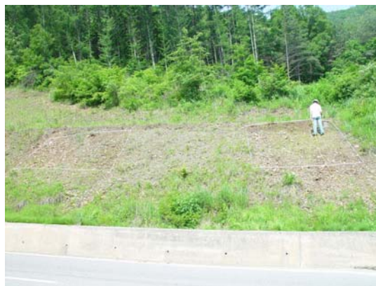
그림 85. Section과 피막형성제 살포.
