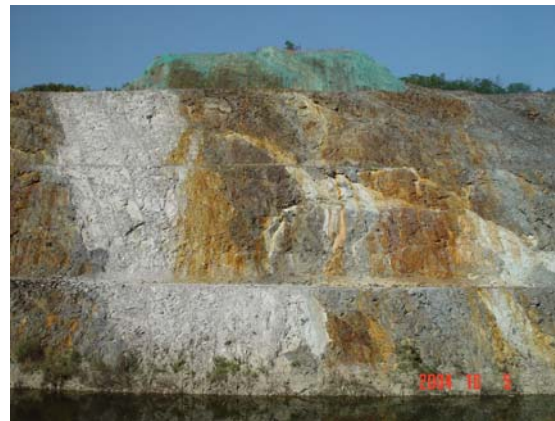
그림 26. 절취사면의 침전물에 의한 경관훼손.
