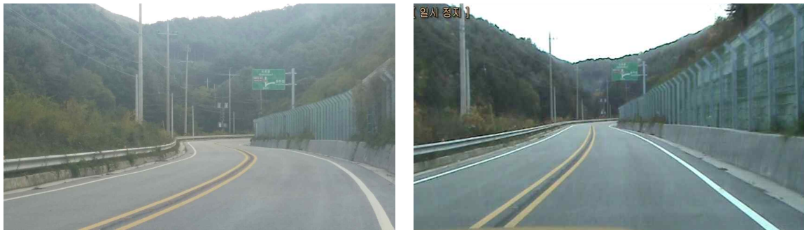
<그림 3.57> 시공 전 · 후
