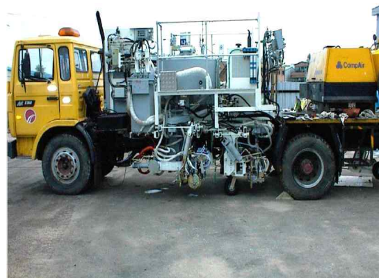
(b) 시공 장비
