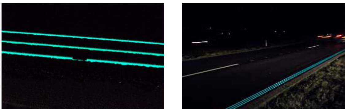
<그림 3.38> 네덜란드 야광 노면표시 현장(Netherlands Oss N329)
