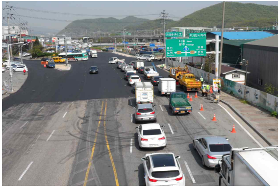
(a) 공사현장 전경
