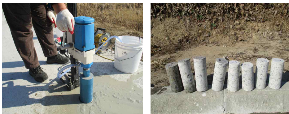
<그림 2.2.8> Mock-up 테스트 콘크리트 코어링
