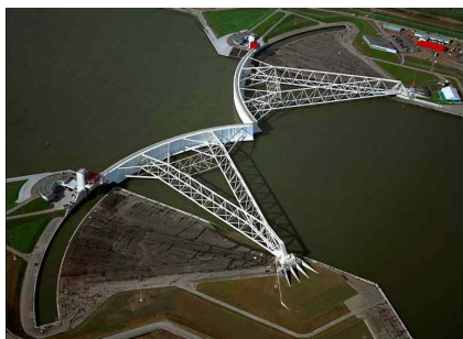
그림 3.2.9 Maeslant Storm Surge Barrier
