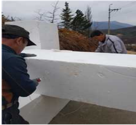
그림 3-37 Geofoam 재단 방법
