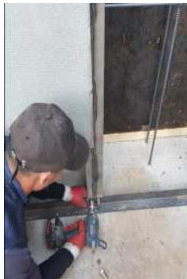
하부 지지대 설치
