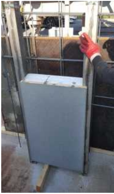
단열 패널 설치
