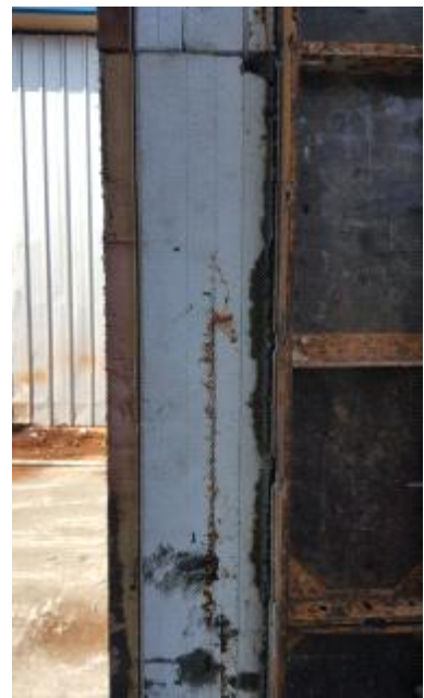
타설 후 측면 상태
