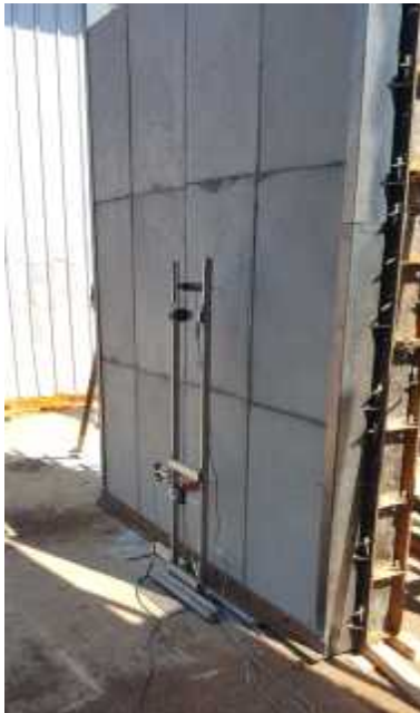
변위 측정 장비 설치
