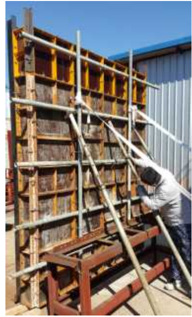
유로폼 지지대 설치
