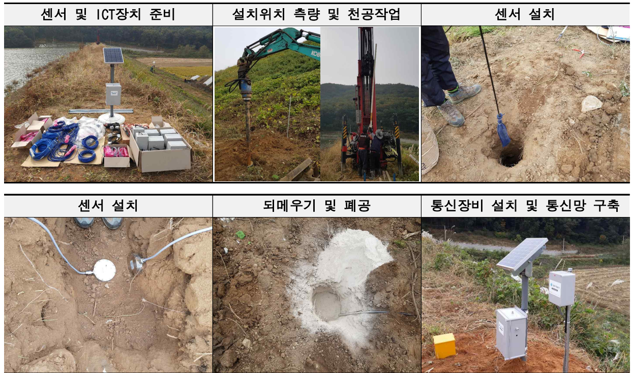
그림 2.24 2차연도 Test bed 단계별 구축과정 및 전경
