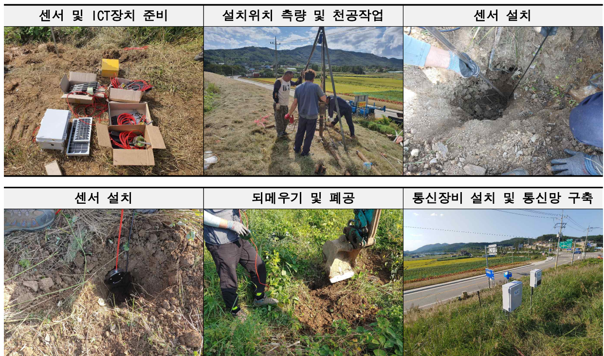
그림 2.34 3차연도 Test bed 단계별 구축과정 및 전경
