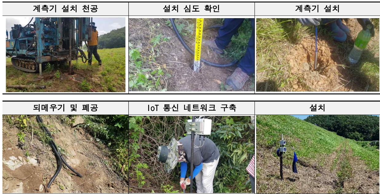
그림 2.10 1차연도 Test bed 단계별 구축과정 및 전경
