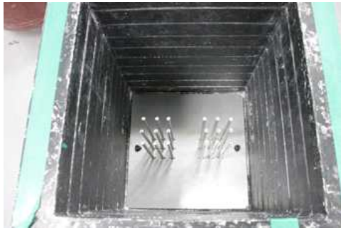
(a) 말뚝 기초 설치
