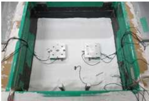
(e) 전면기초 설치
