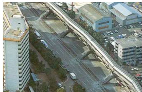
그림 24. 얇은 기초의 현행 내진설계 개념 그림 25 현행 설계 개념으로 설계된 교량의 붕괴
