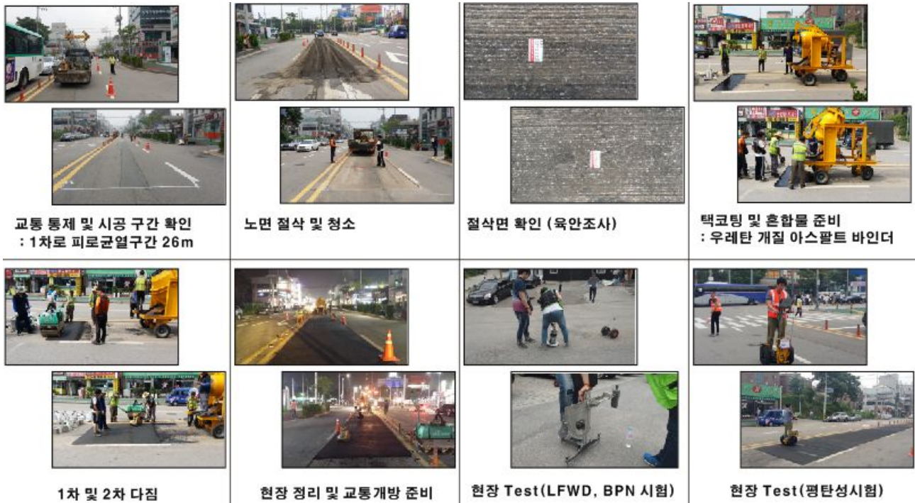
그림 2.58 우레탄 개질 아스팔트 슬러리실 3차 시험 시공 절차 및 결과
