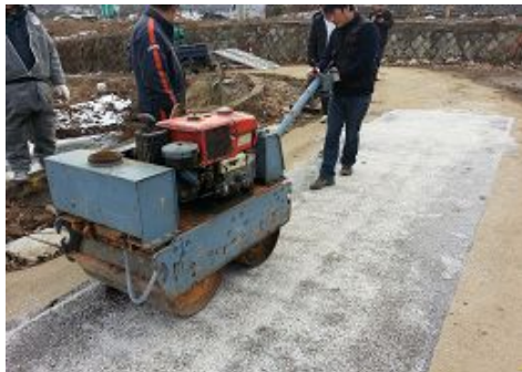
(f) 노즐상태 및 분사량 확인, 골재 분포 상태 확인
