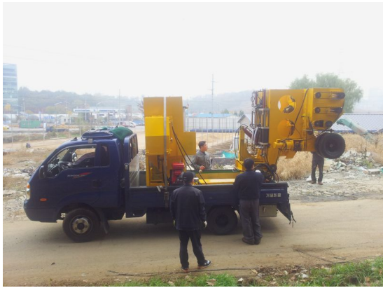
UMAB 칩실 시공 장비 이동 모드
