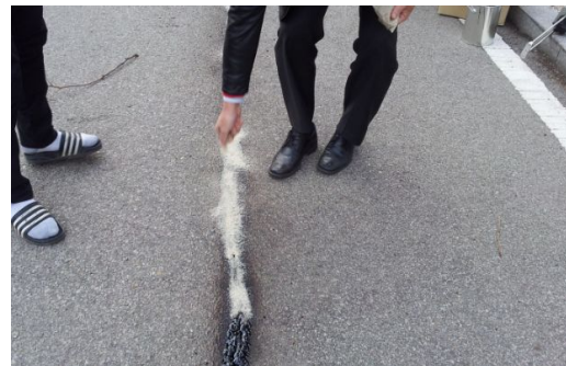
(b) 균열 실링
