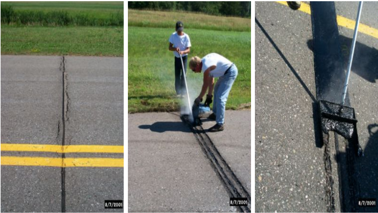
그림 1.2 실링에 의한 포장 균열 보수
