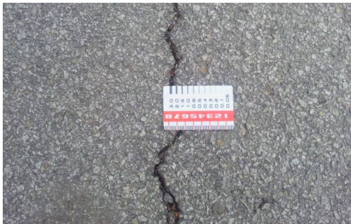
(a) 균열 조사 및 청소
