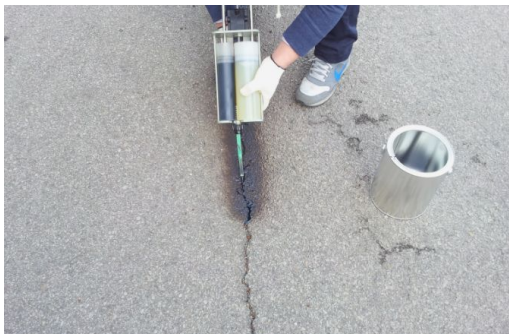
(a) 균열 조사 및 청소
