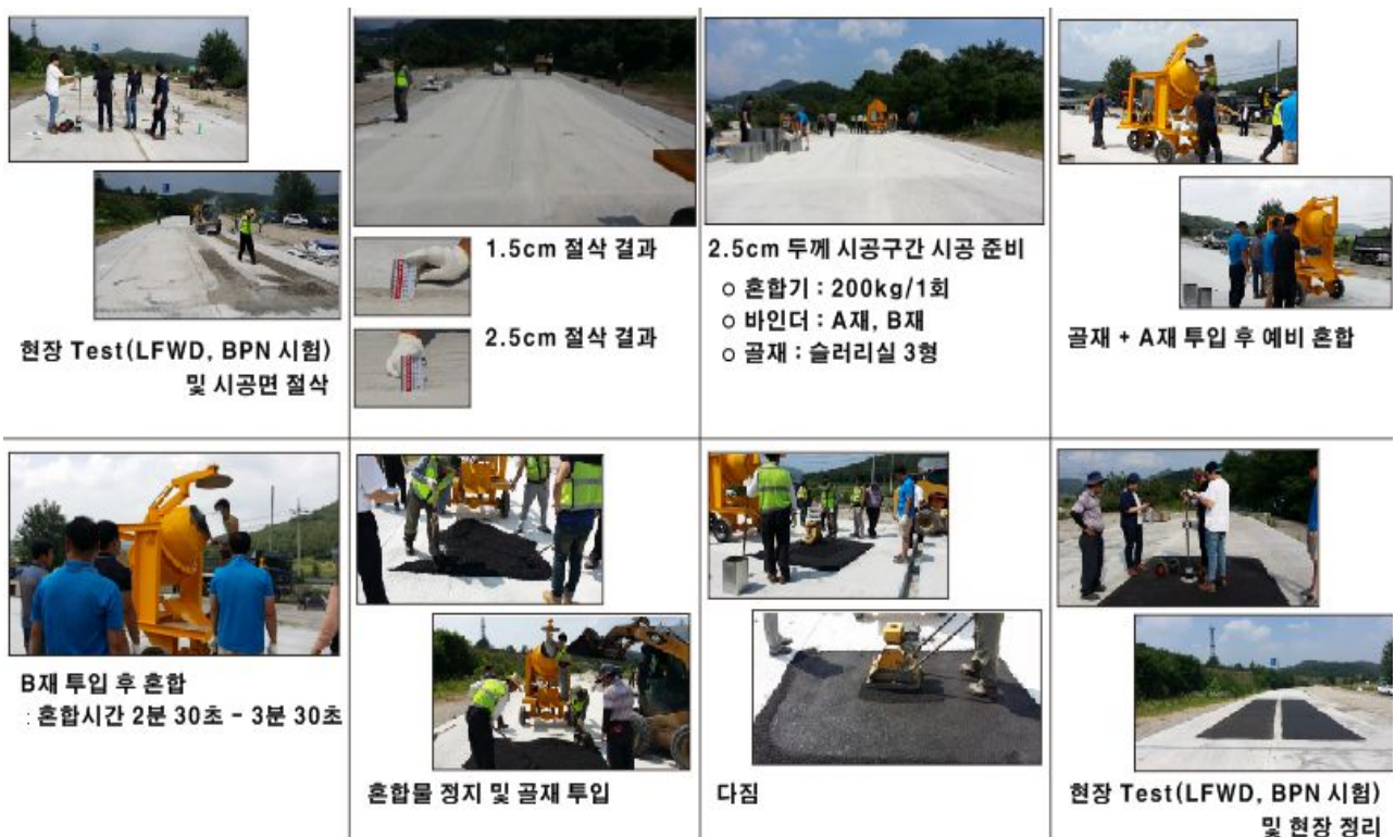
그림 2.48 우레탄 개질 아스팔트 슬러리실 2차 시험 시공 절차 및 결과
