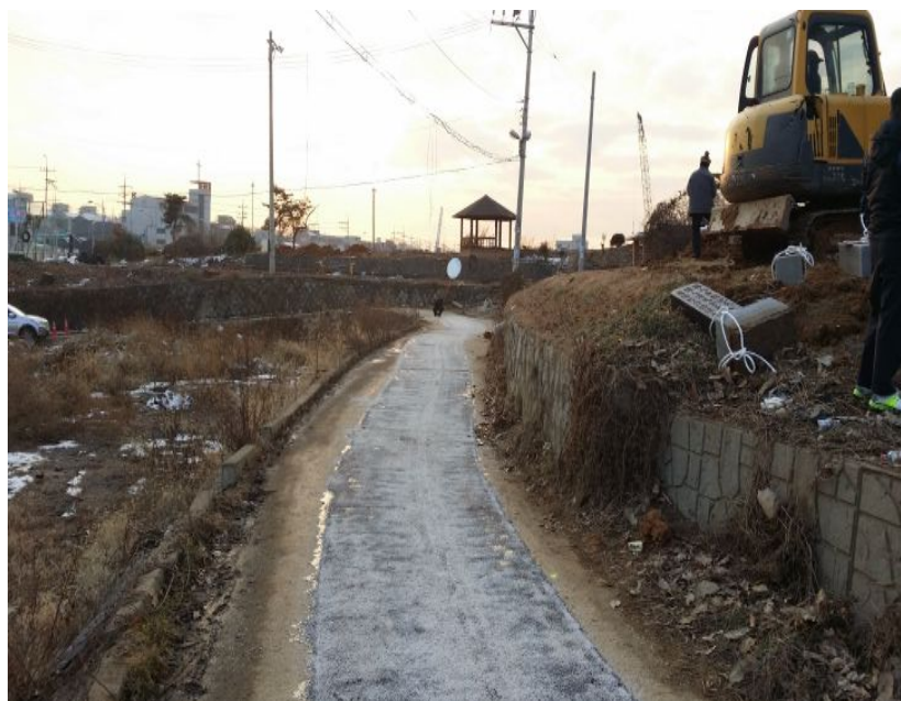
(b) 시험 시공 후 시공 현장 전경 그림 2.32 칩실 시공 결과
