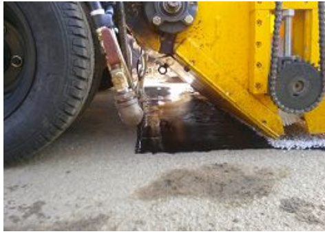
(e) 노즐상태 및 분사량 확인, 골재 분포 상태 확인
