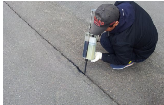
(b) 균열 실링
