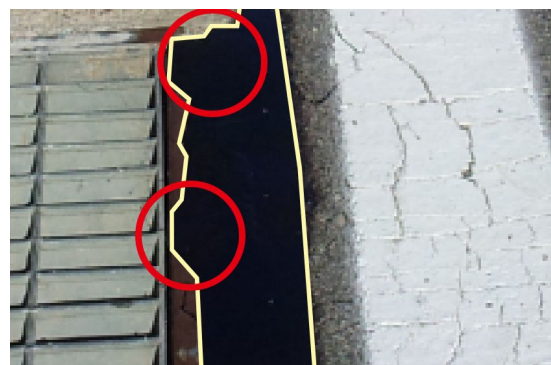
그림 2.69 2차 시공이음 균열부 균열 실링 시공 결과
