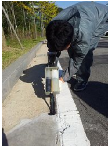
(b) 균열 실링재 주입
