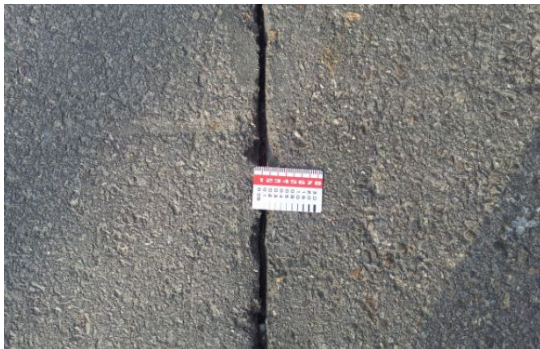
(a) 균열 조사 및 청소
