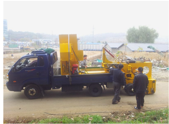
UMAB 칩실 시공 장비 시공 모드
