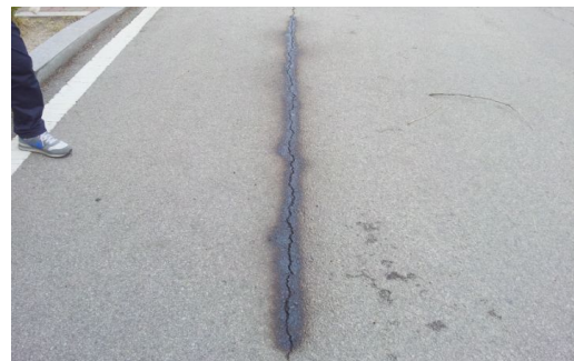
(b) 균열 실링
