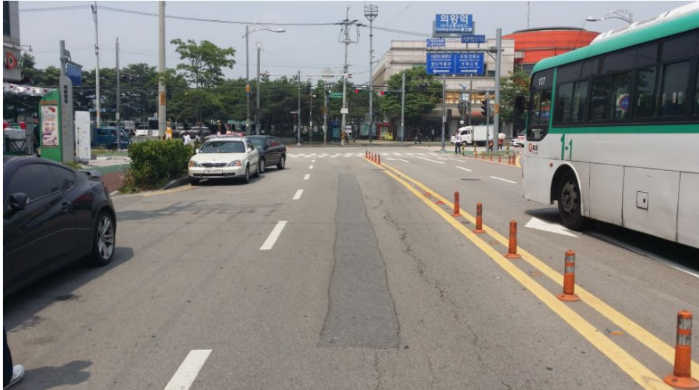
그림 2.56 우레탄 개질 아스팔트 슬러리실 3차 시험 시공 구간 현장 조사
