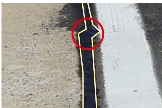
그림 2.69 2차 시공이음 균열부 균열 실링 시공 결과
