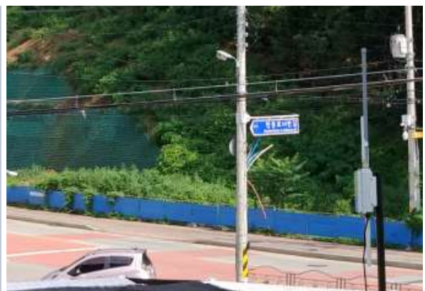
(b) 통신중계기 설치 후
