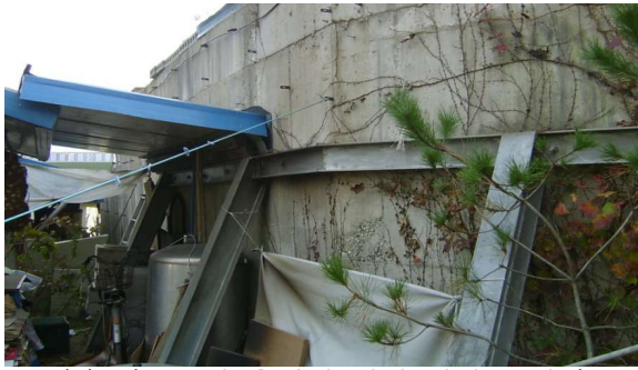
(e) 전도우려 옹벽에 대한 버팀보 설치
