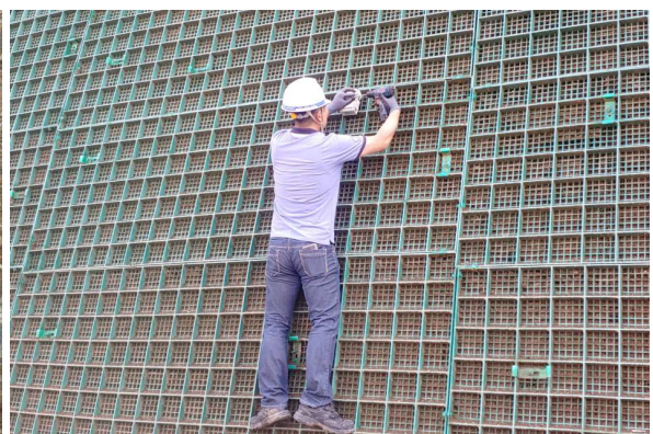
(b) 유지관리키트(경사계 3) 설치 후
