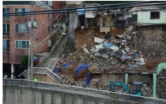
(b) '14 부산부암동 석축붕괴로 인한 주택 붕괴
