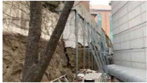
(f) 전도우려 옹벽에 대한 버팀보 설치
