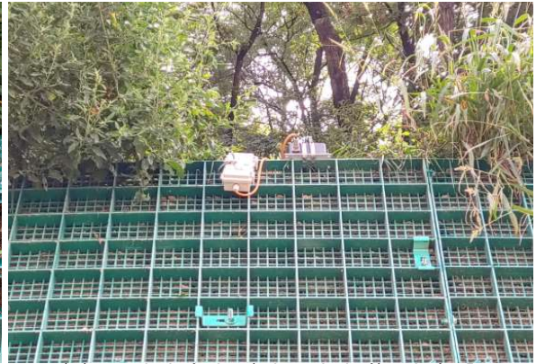
(b) 유지관리키트(지표변위계) 설치 후
