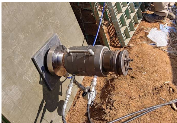
(a) 식생패널 설치전 영구앵커 시공 및 로드셀 설치
