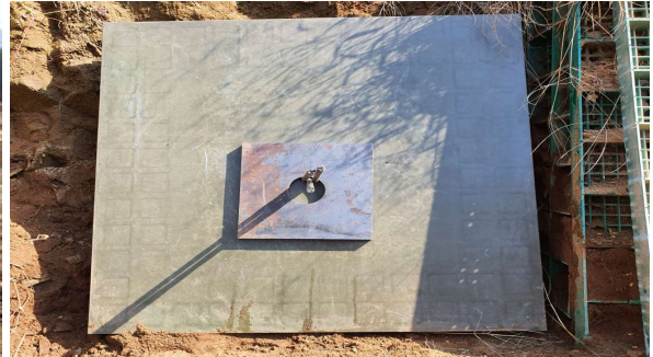
(h) 영구앵커 지압판 설치
