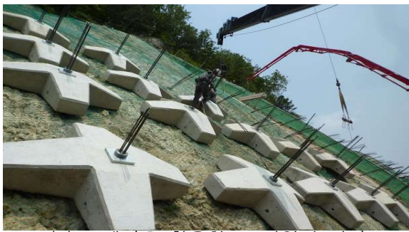
(a) 크레인을 활용한 RC지압판 설치
