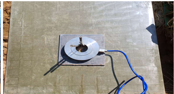
(f) 로드셀 설치
