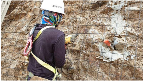
(e) 와이어메쉬 설치
