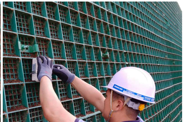
(b) 유지관리키트(경사계 2) 설치 후
