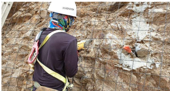
(e) 와이어메쉬 설치
