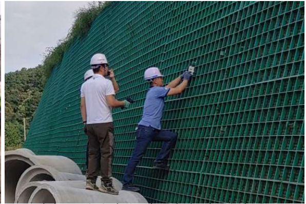
(b) 유지관리키트(경사계 1) 설치 후
