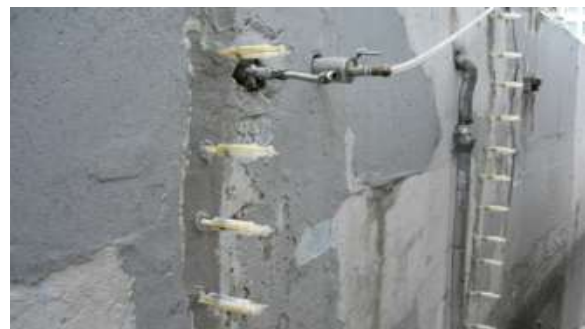
(d) 옹벽 균열 보수
