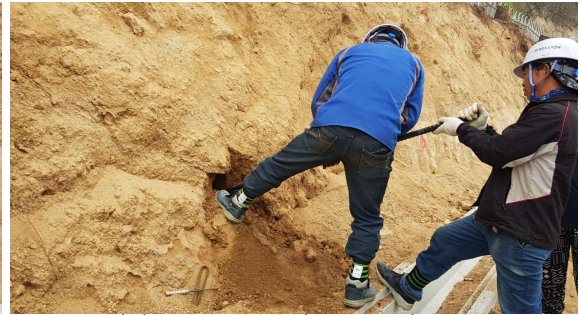
(b) 보강재 설치 및 그라우팅
