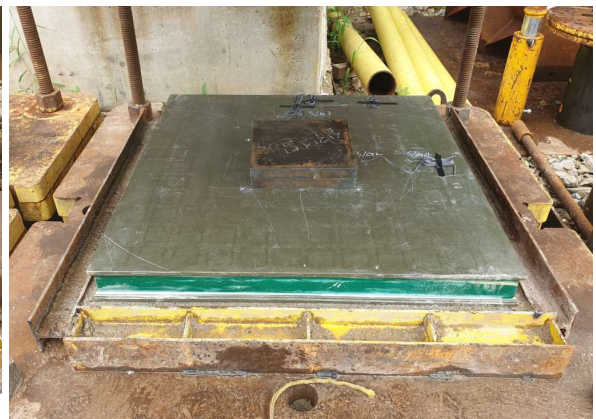
(b) 앵커지압판 및 steel plate 거치
