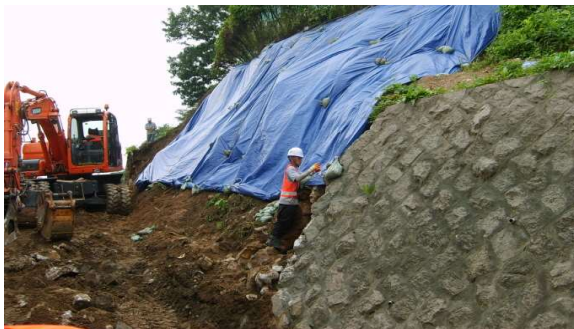
(a) 노후 석축 철거 후 신규구조물 축조
