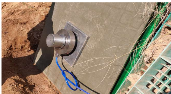
(i) 앵커 보호캡 설치(앵커공 마무리)
