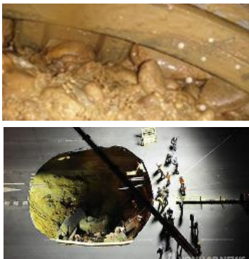
시공 중 굴착 효율성 저하, 공사 중/운용 중 안전 재해 발생
