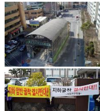
수직구 공사 도로점유 장기화, 터널 발파 및 굴착 진동
