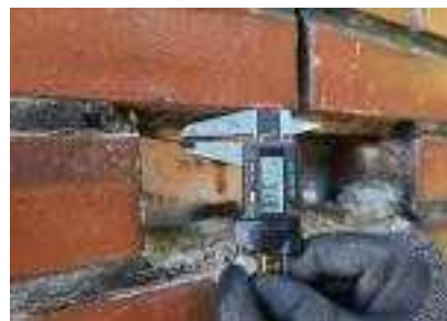
<연결철물 직경 측정>
