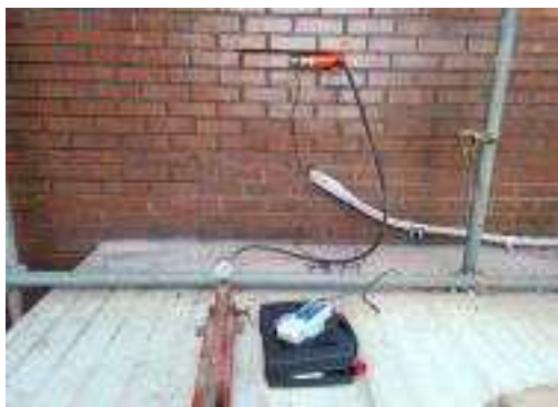
① 유압실린더 및 로드셀 설치 모습
