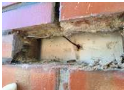
<치장벽돌 내 설치된 단열재 모습>
