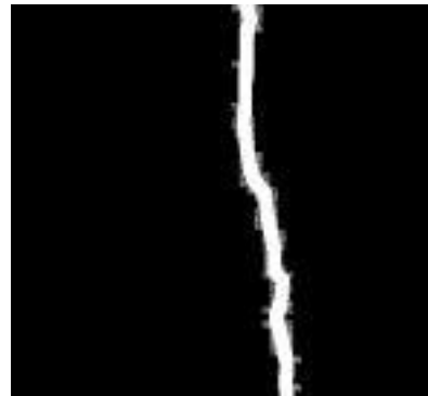
균열 부위 마스크 이미지
