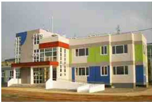
그림 2-51. 선행 연구단 Mockup House
