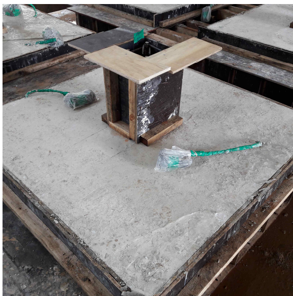
[그림 37] 상부 기둥 콘크리트 타설 준비 및 타설
