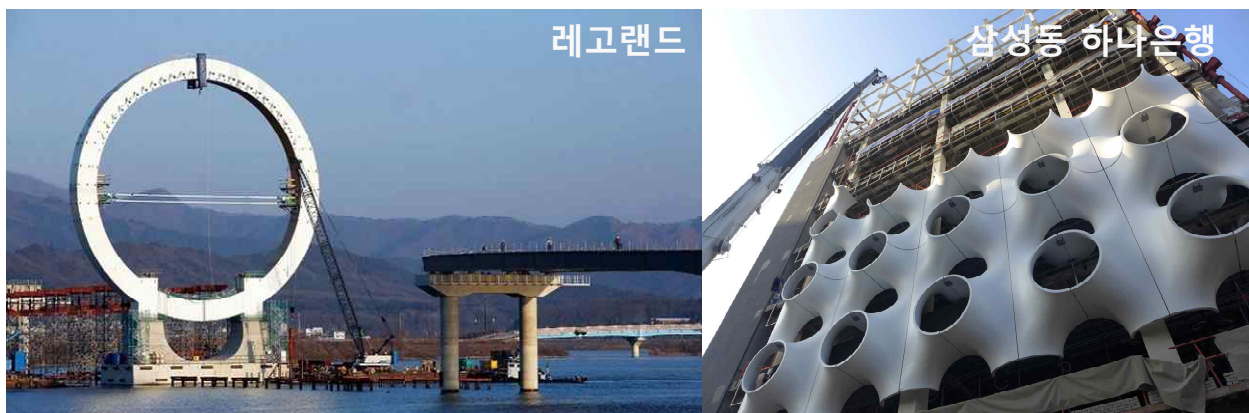
[그림 3] 초고성능 콘크리트의 사용 예시
