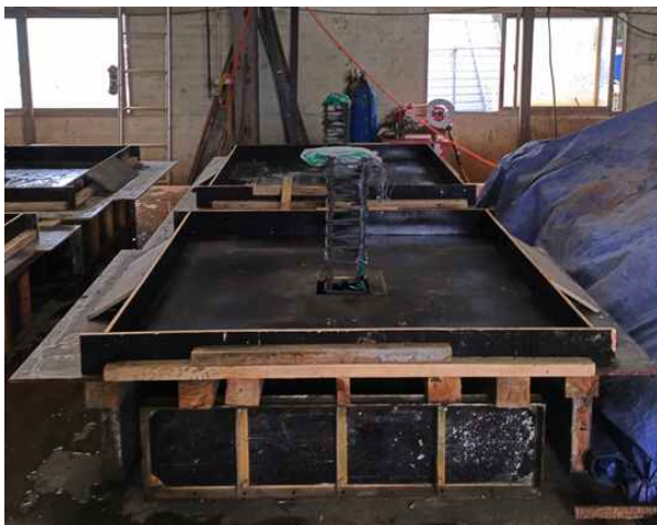
[그림 33] 철근망의 설치
