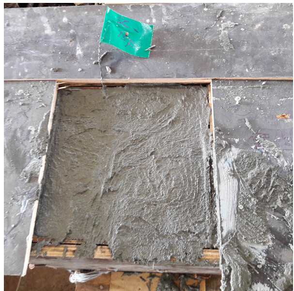
[그림 37] 상부 기둥 콘크리트 타설 준비 및 타설
