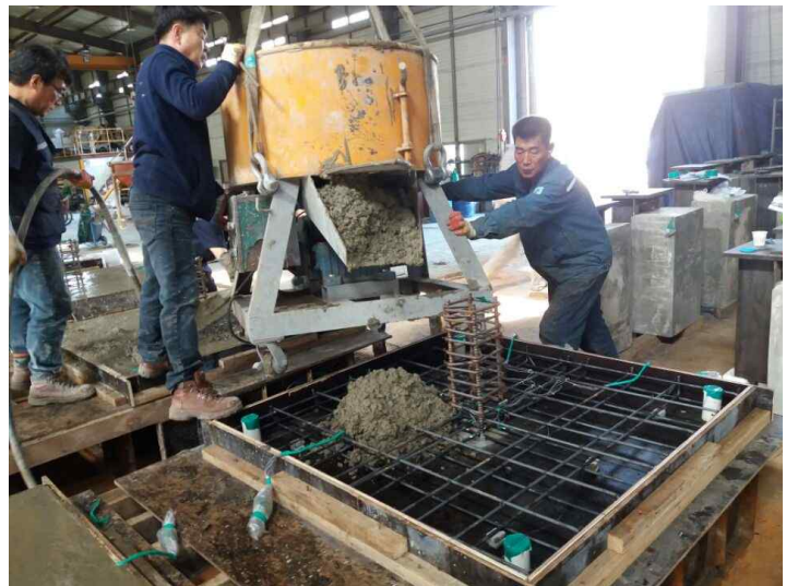
[그림 36] 슬래브 콘크리트 타설
