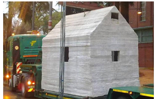
그림 26 A complete 3D printed house by using D-shape
