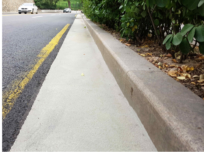
[그림3.45] 시공 30일 후 Section 5 포장 상태
