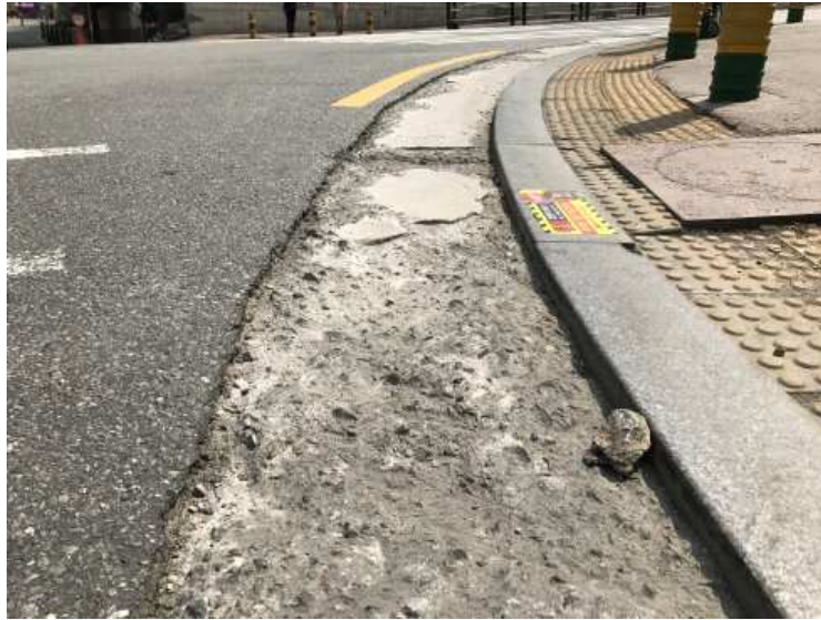
[그림3.49] 시공 30일 후 Section 7 포장 상태
