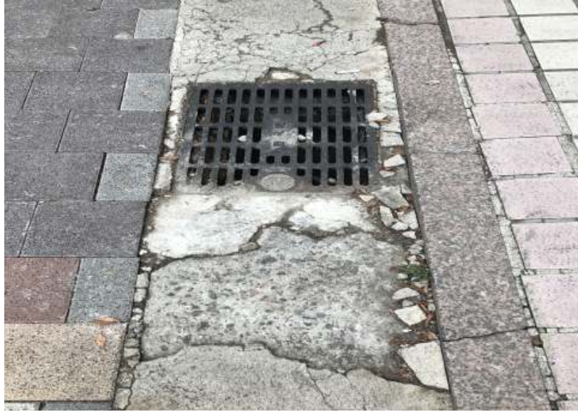
[그림3.42] 시공 30일 후 Section 3 포장 상태
