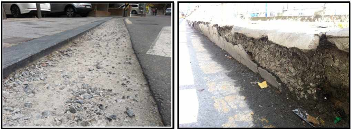
[그림 1.1] 측구 및 경계석 현실태
