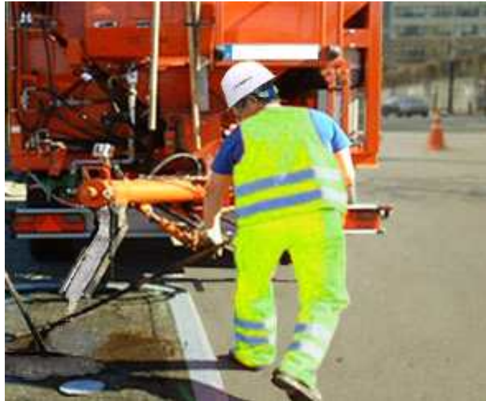
[그림 3.58] 측구보수 전용장비 포설 사진
