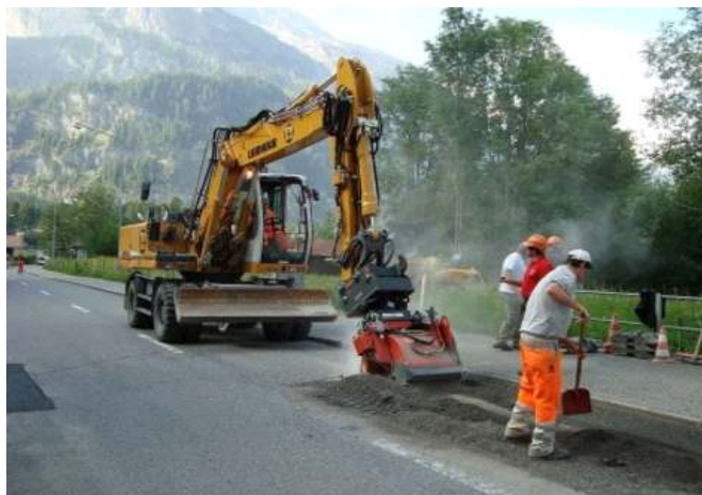
[그림 3.1] 노면파쇄기를 이용한 콘크리트 측구절삭과 재설치
