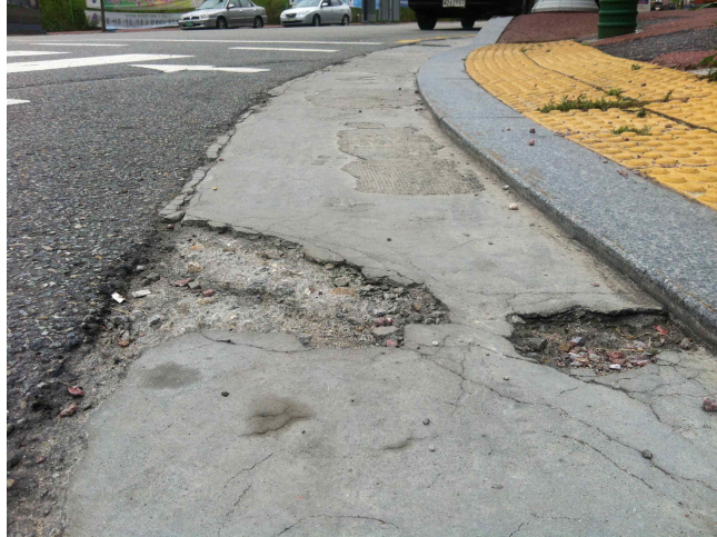
[그림3.38] 시공 30일 후 Section 1 포장 상태
