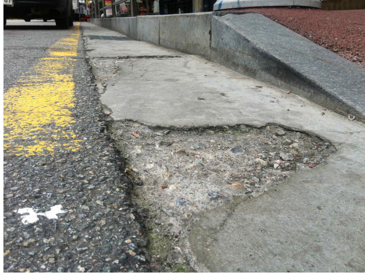
[그림3.40] 시공 30일 후 Section 2 포장 상태
