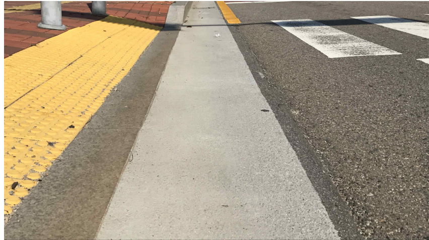
[그림3.47] 시공 30일 후 Section 6 포장 상태
