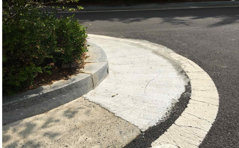
[그림3.43] 시공 30일 후 Section 4 포장 상태
