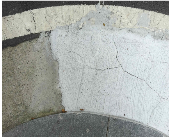
[그림3.53] 시공 30일 후 Section 9 포장 상태
