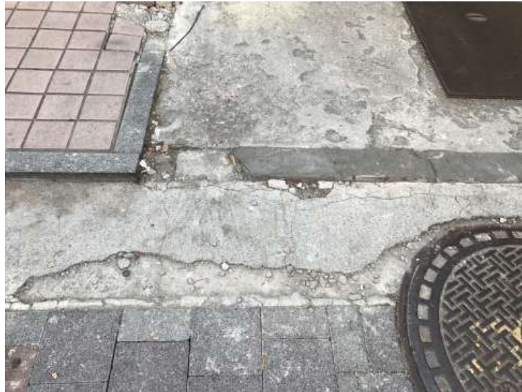
[그림3.51] 시공 30일 후 Section 8 포장 상태
