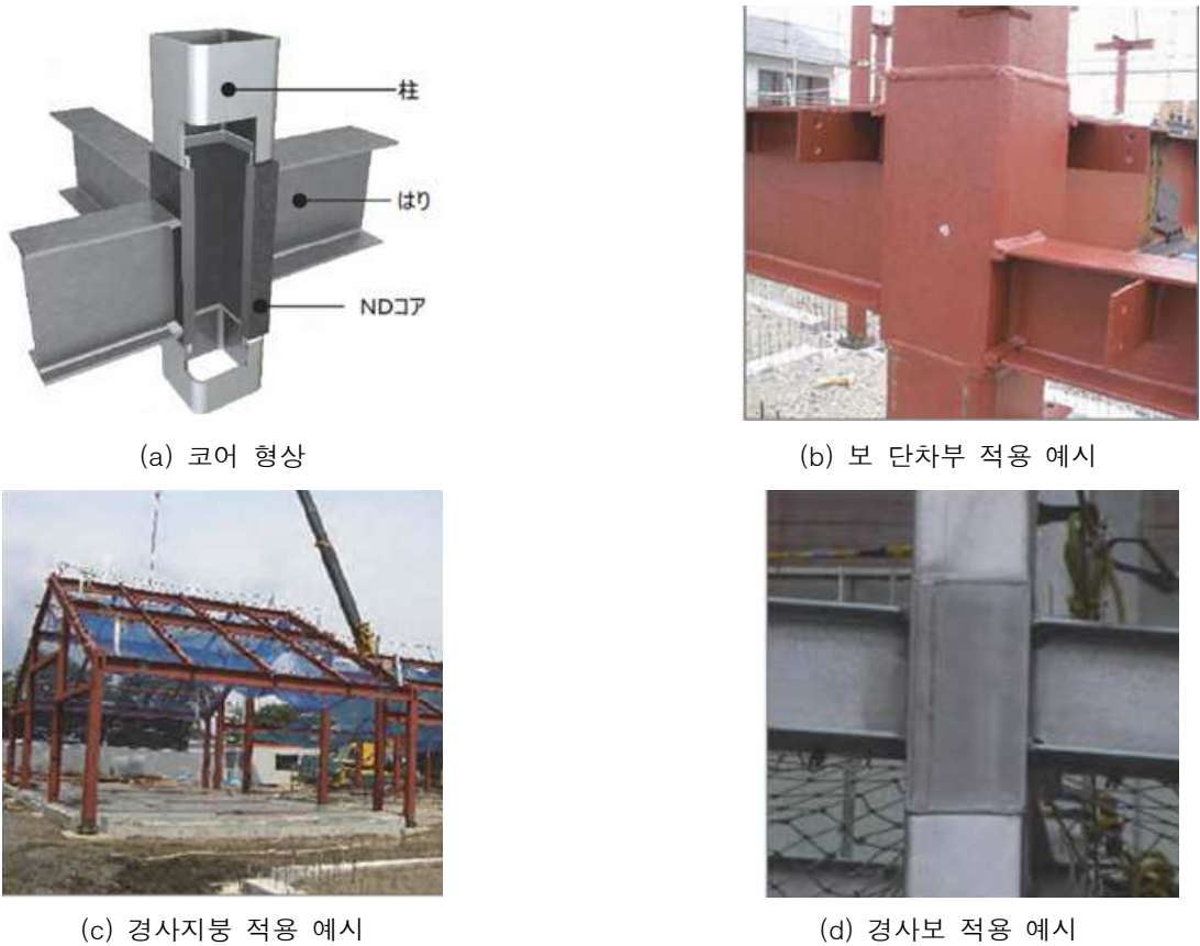
그림 2.6 ND(Non-Diaphragm)코어 형상 및 적용 예시
