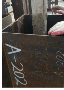
(b) Concrete Pouring
